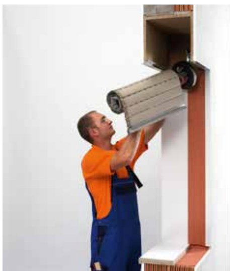
Retirer l'ancien tablier de volet roulant du caisson
